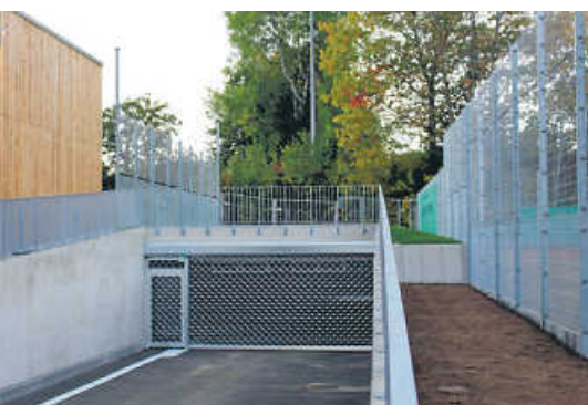
Einfahrt zur Tiefgarage mit rund 65 Stellplätzen.
