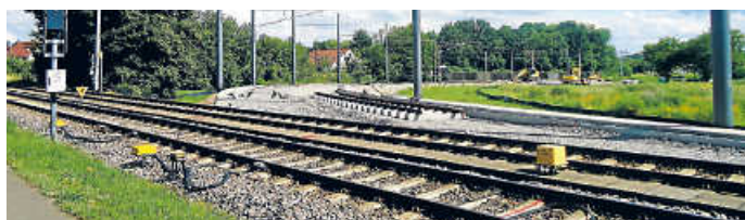
Gleisverlegung an der „Pflugmühle“-Kurve.
