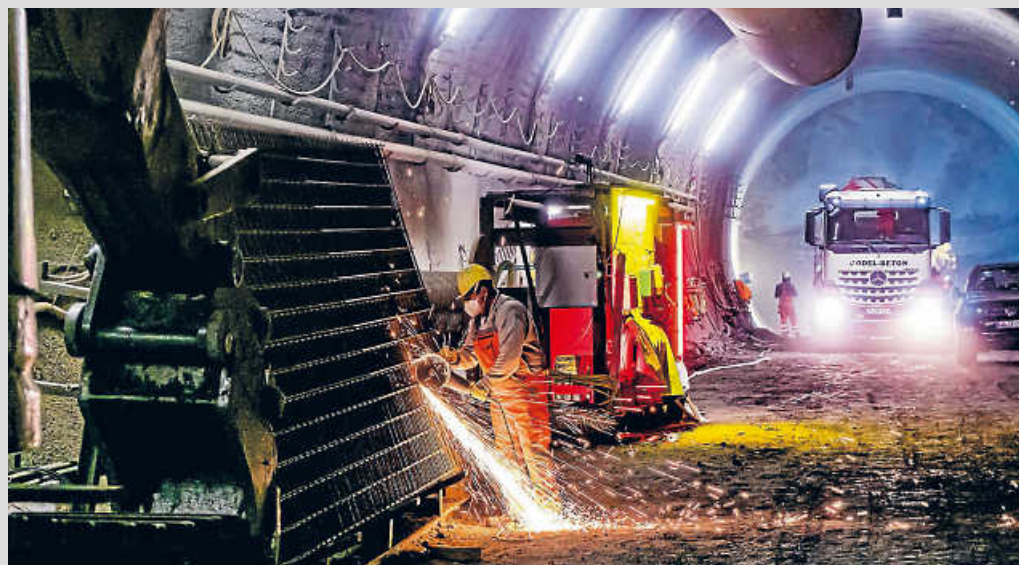
„Bergfest“ bei den Bauarbeiten für den Flughafentunnel. Foto: DB Projekt Stuttgart-Ulm GmbH/Arnim Kilgus
