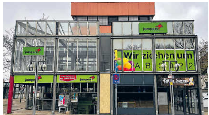
Aldi wird in das Untergeschoss im Berolinahaus einziehen. Foto: fr
